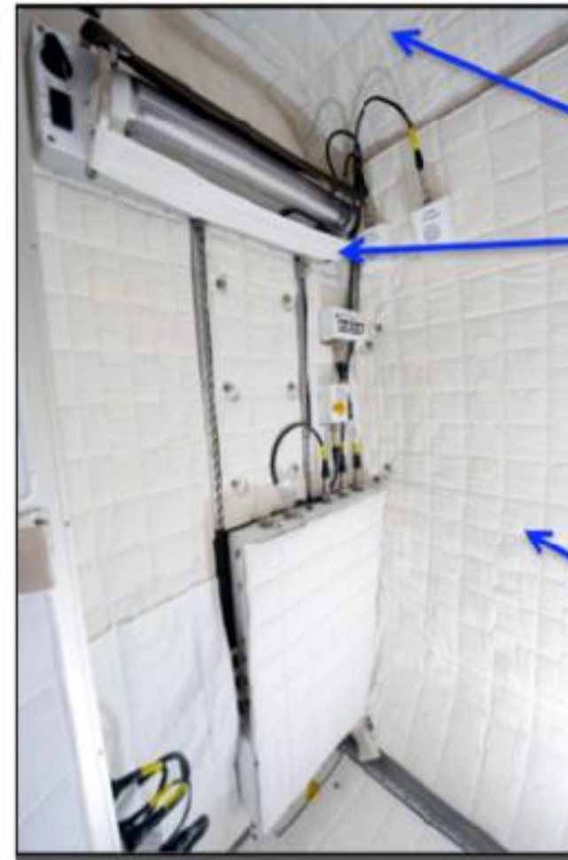
Рис. 22. Помещение для экипажа на американском сегменте МКС с защитой от радиации полиэтиленом (По: Schlesinger T.P. et al. International Space Station Crew Quarters On-Orbit Performance and Sustaining [21]).
